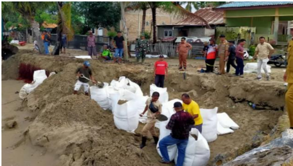
Gambar 4. Masyarakat Mengisi Tanah Ke Dalam Goni Berguna Sebagai Penghalang Ombak
